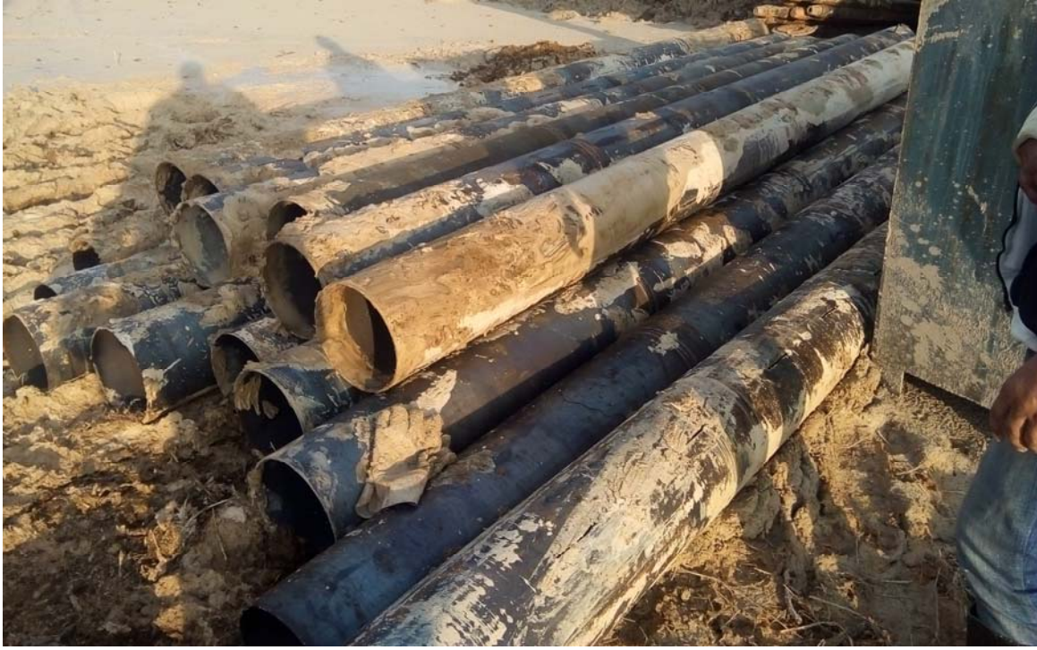
مواسير التغليف الداخلي بلاك ستيل قطر 10 انش سماكة 5 ملم
