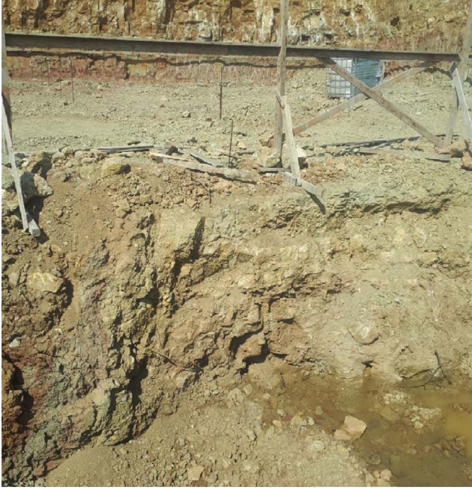
صورة تظهر حدود العقار من الجهة الجنوبية ومستوى اساسات الحفر ومستوى خروج مياه عين برق
