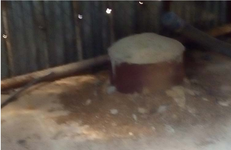
صورة تظهر فوهة البئر الخاص ممتلئة بالاسمنت
