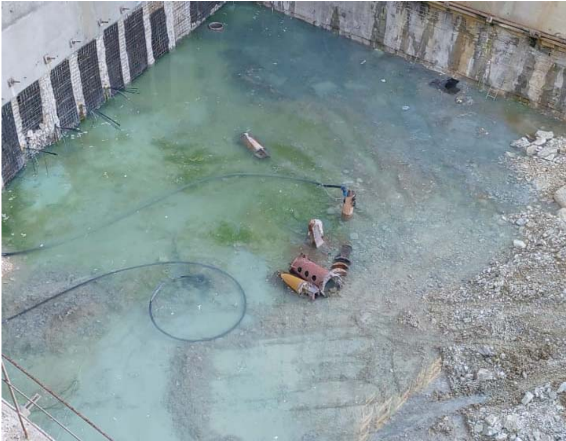
صورة بالقرب من البئر W07 توضح امتلاء الحفرة بالمياه عند توقف ضخ المياه فيرتفع منسوب المياه الجوفية
